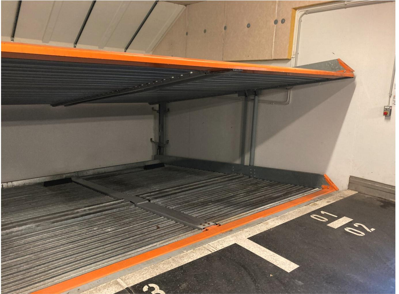
Bringen Sie Pkw mit hydraulischer Höhenverstellung in Mittelposition!
