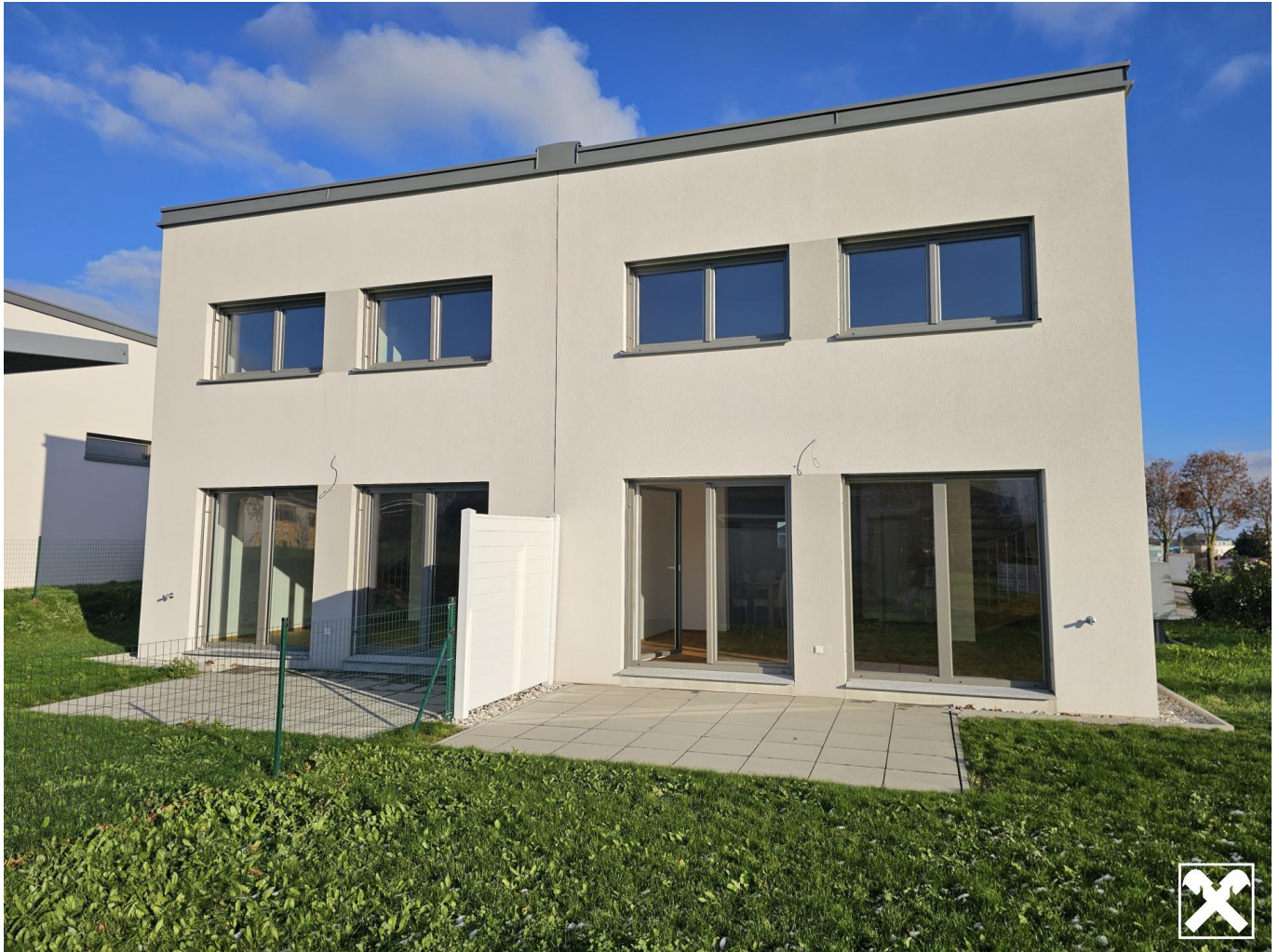
Südseitige Aussenansicht von 2 Doppelhaushälften
