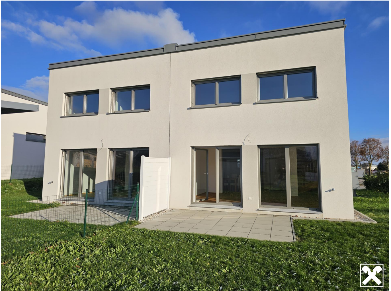
Südseitige Aussenansicht von 2 Doppelhaushälften
