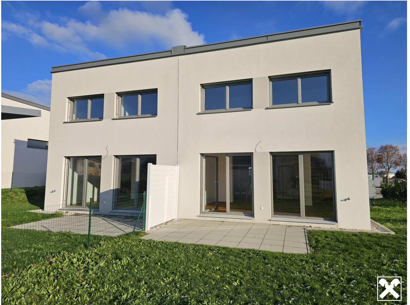
Südseitige Aussenansicht von 2 Doppelhaushälften
