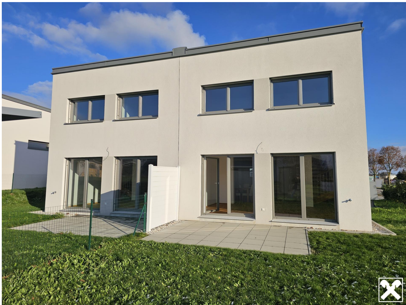
2 Doppelhaushälften Aussenansicht Haag Salaberg
