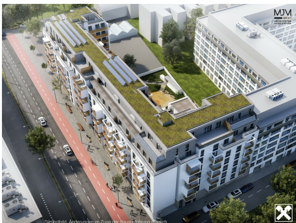
Symbolbild, Änderungen im Zuge der Bauausführung möglich
