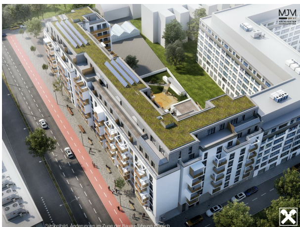
Symbolbild, Änderungen im Zuge der Bauausführung möglich
