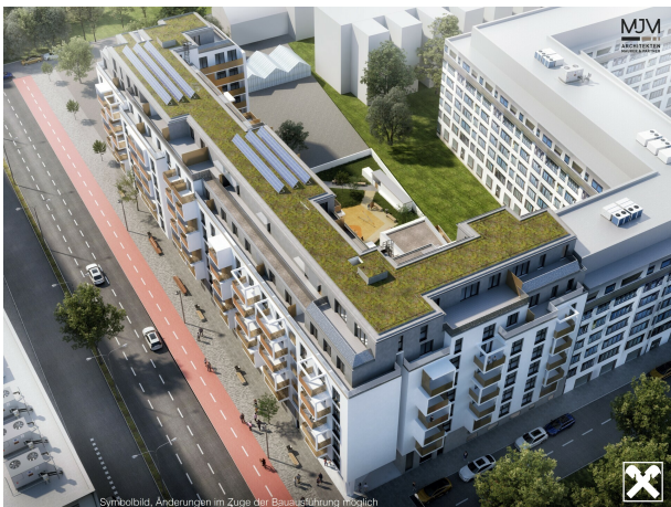
Symbolbild, Änderungen im Zuge der Bauausführung möglich
