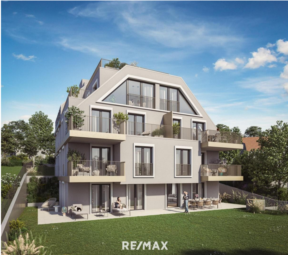
Terrassen und Balkone
