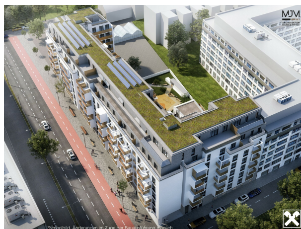
Symbolbild, Änderungen im Zuge der Bauausführung möglich
