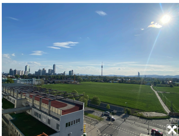
Symbolbild, Änderungen im Zuge der Bauausführung möglich
