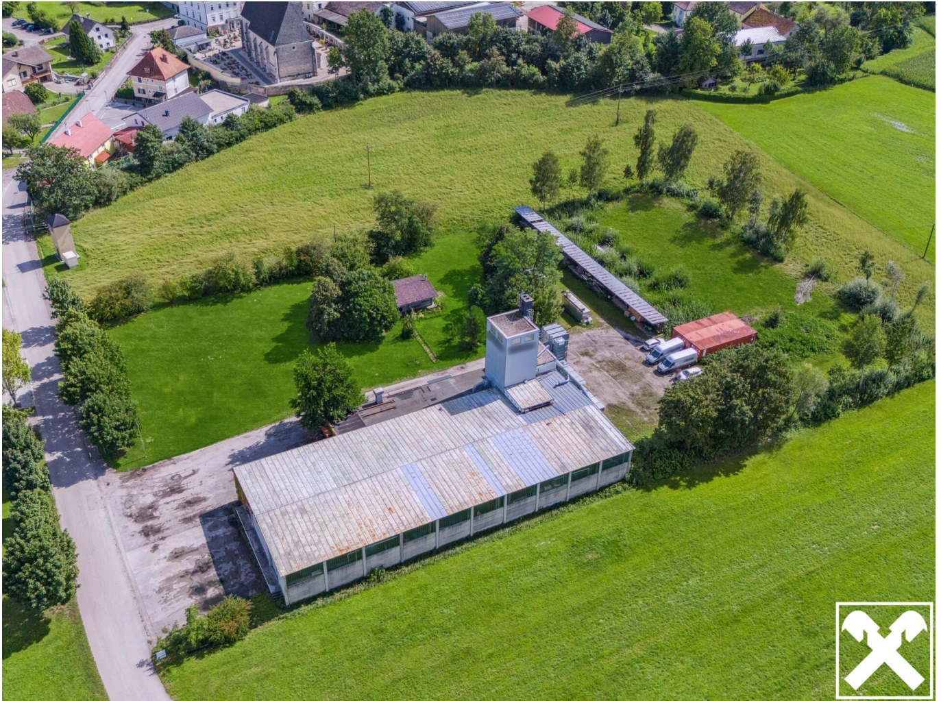
Produktionshalle mit Nebenräumen
