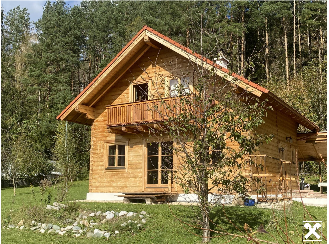
Südseite und Eingangsansicht
