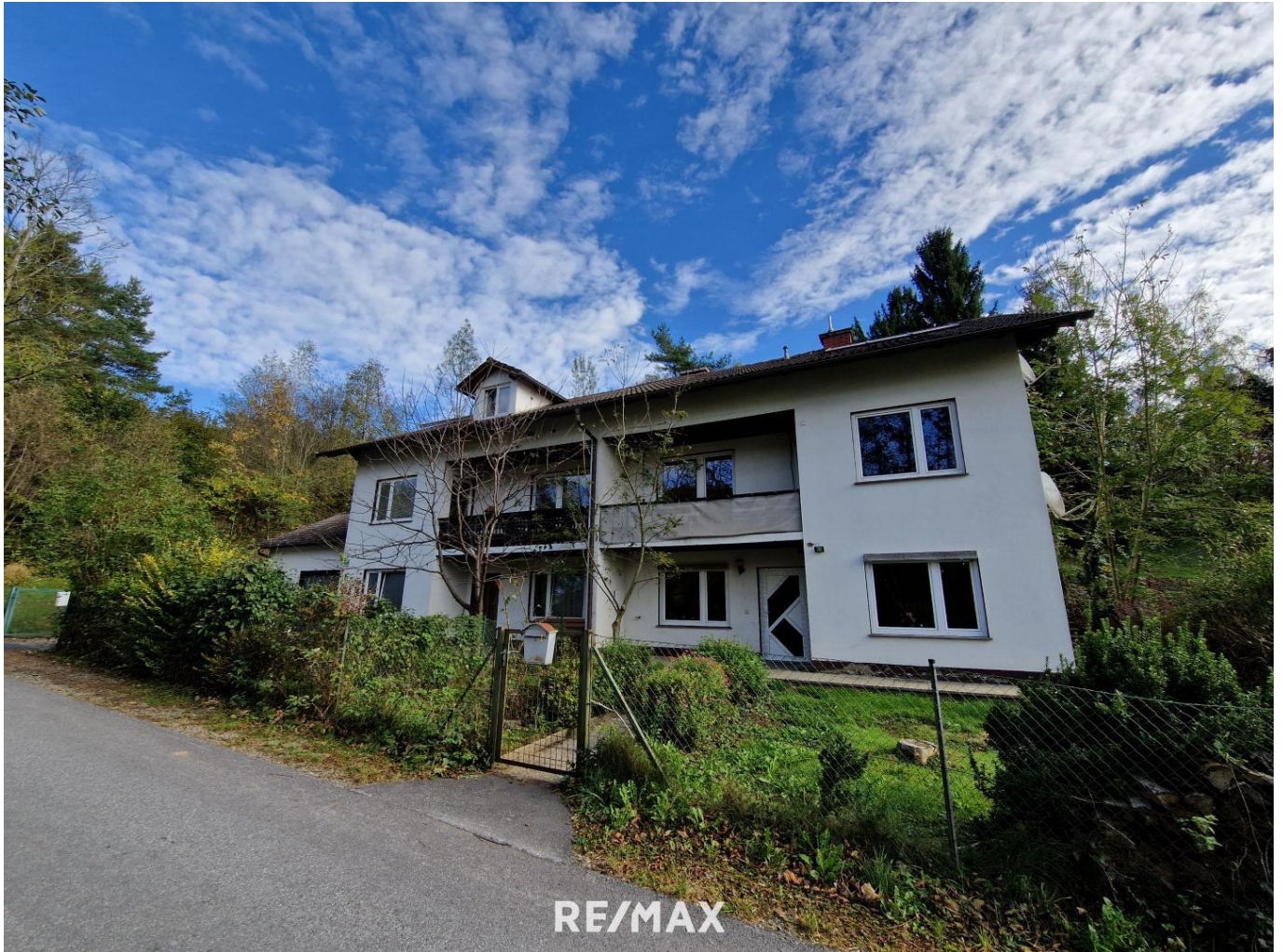
Haus Ansicht Straße
