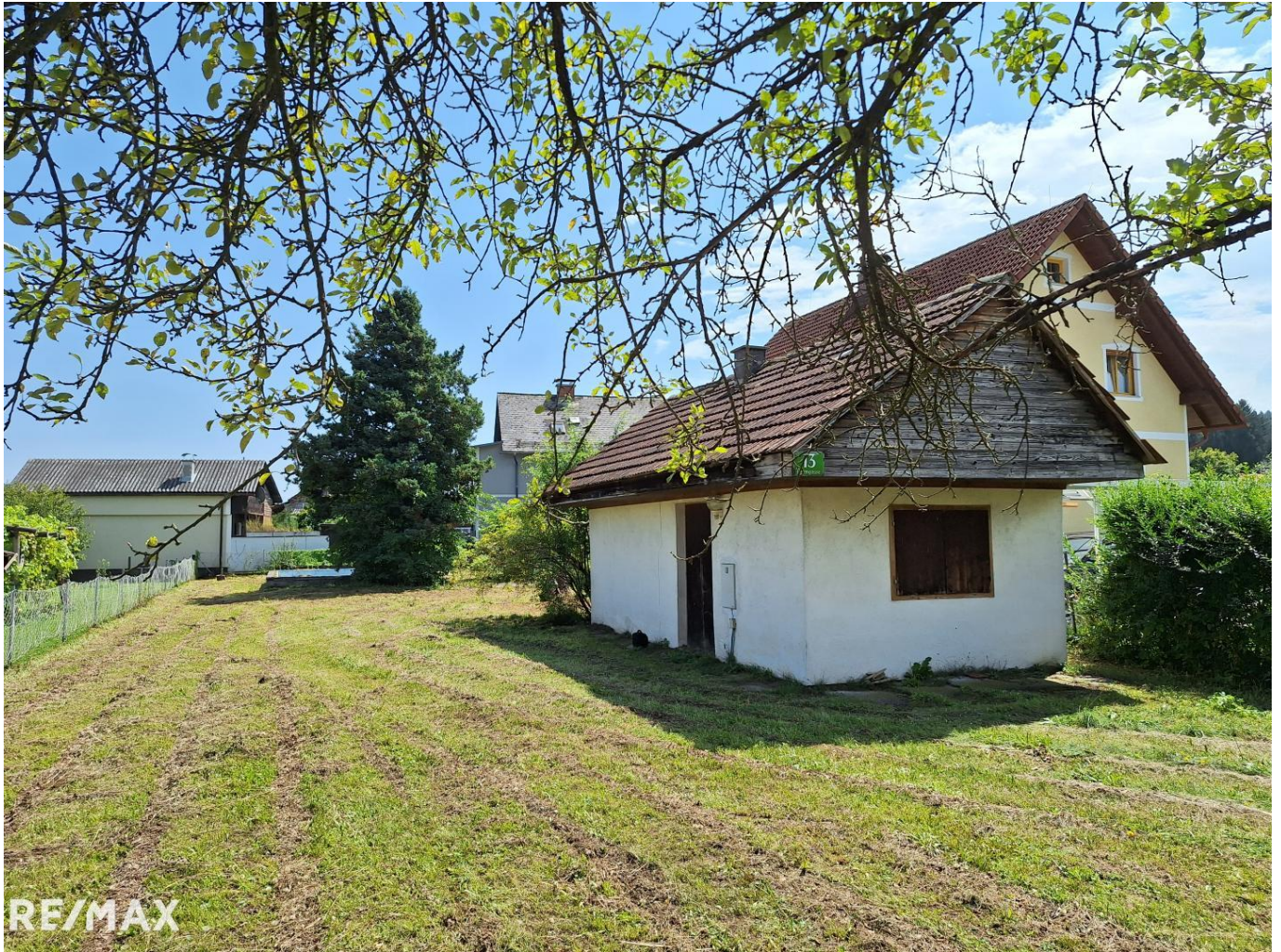
Ansicht aus Nordwest mit Bauhütte
