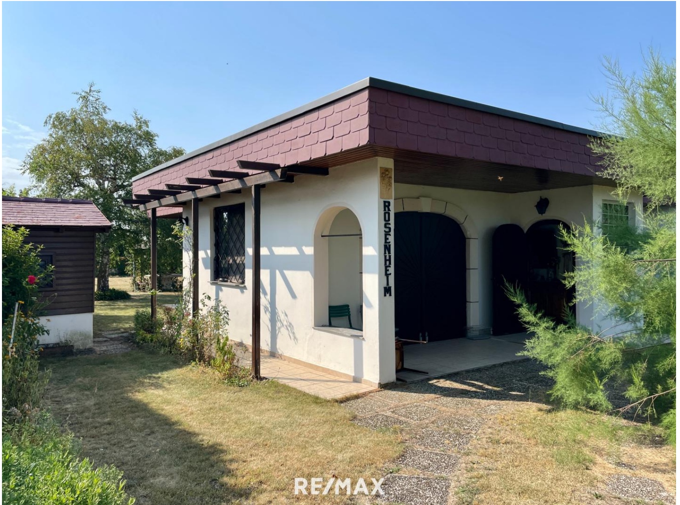
1. Ansicht von außen
