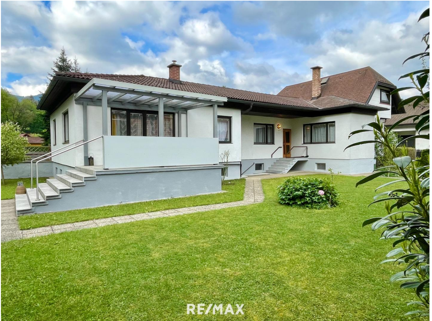
1. Haus von außen
