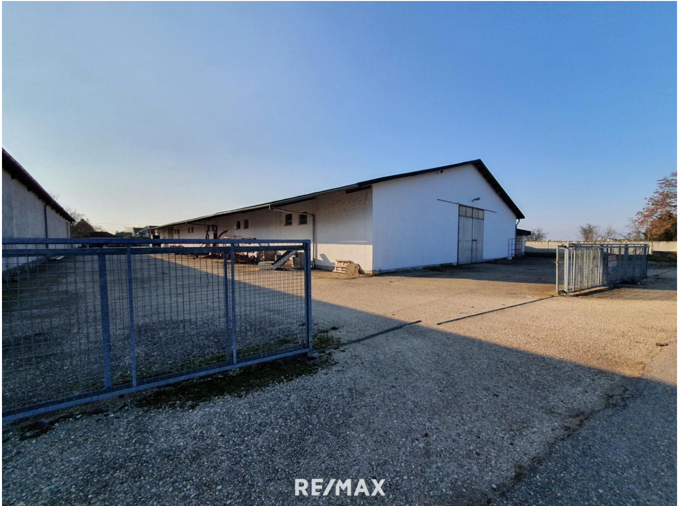
1. Lagerhalle mit Freiflächen
