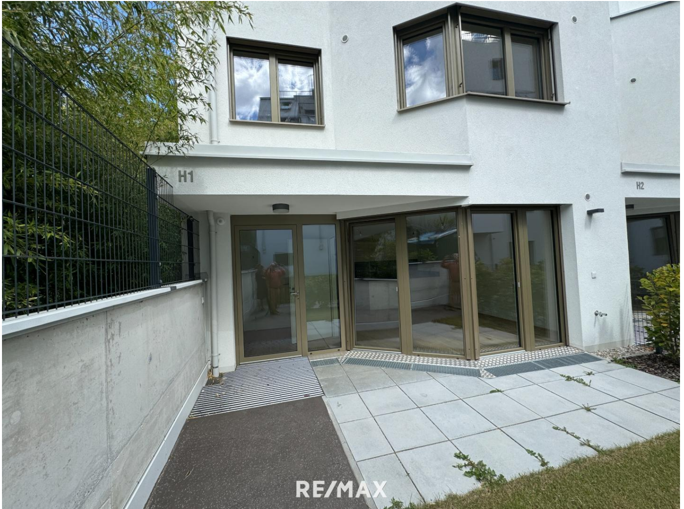
1.Terrasse 1 mit Hauseingang
