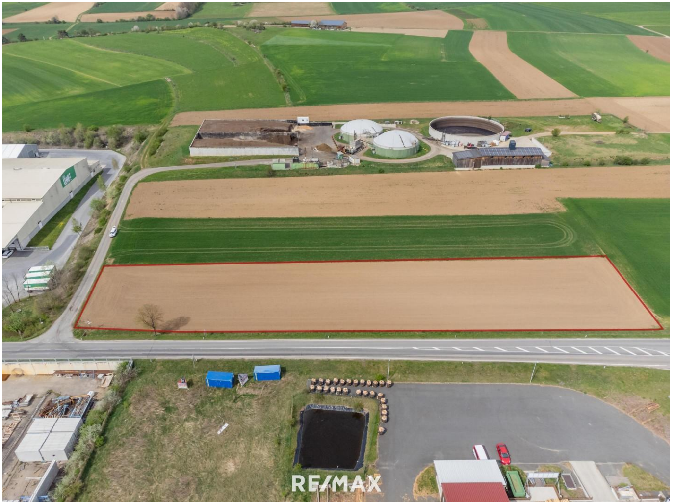
Grundstück Ansicht Nord
