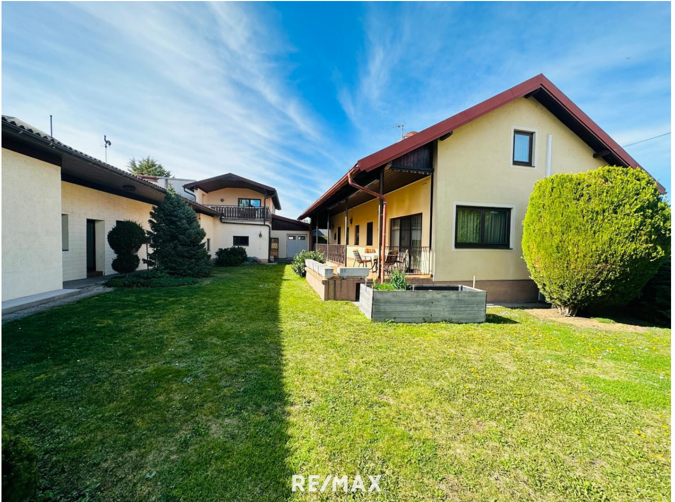
Haus Gartenansicht und Nebengebäude
