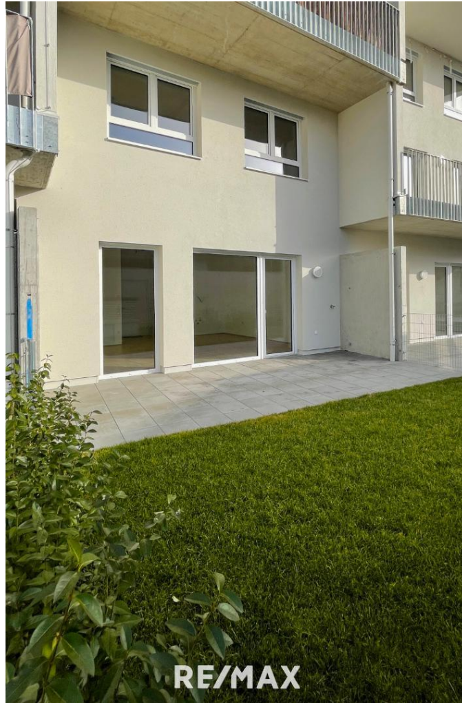
Garten Terrasse - Beispiel 1. Bauabschnitt
