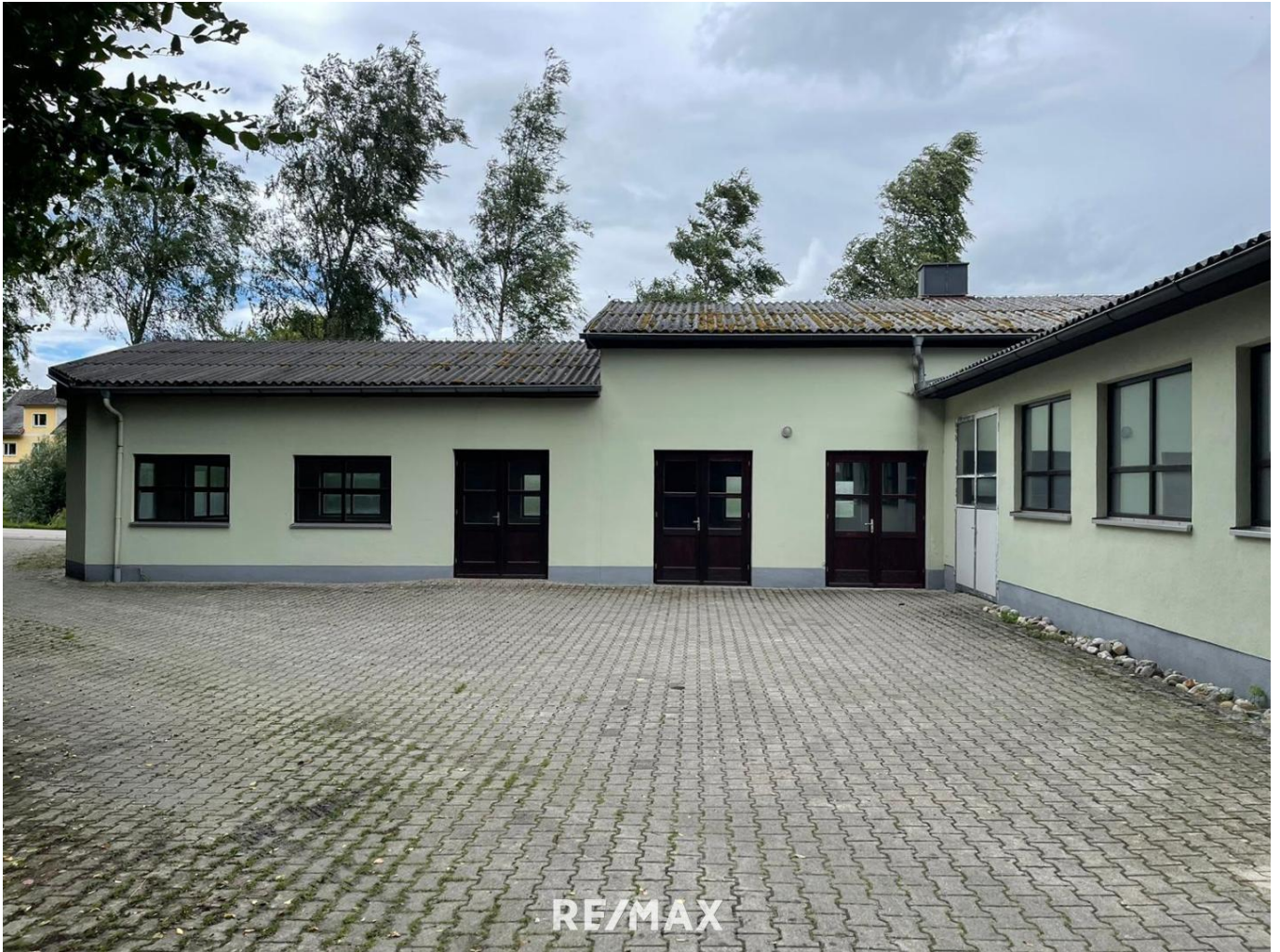
Vorplatz Innenhof - Anlieferseite
