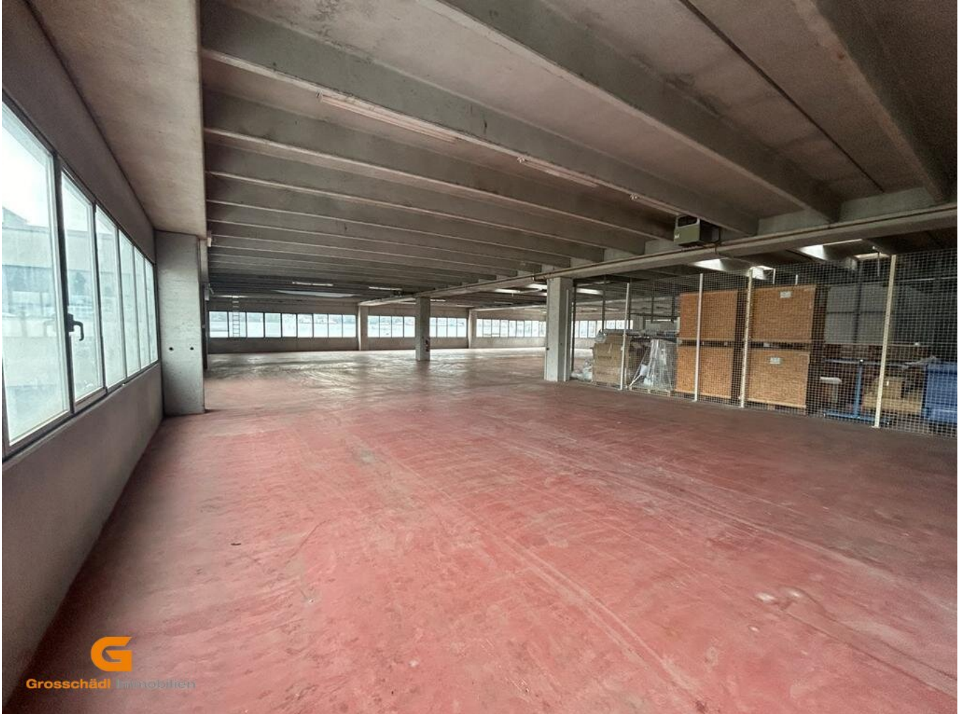
Lager Rückgebäude 1OG
