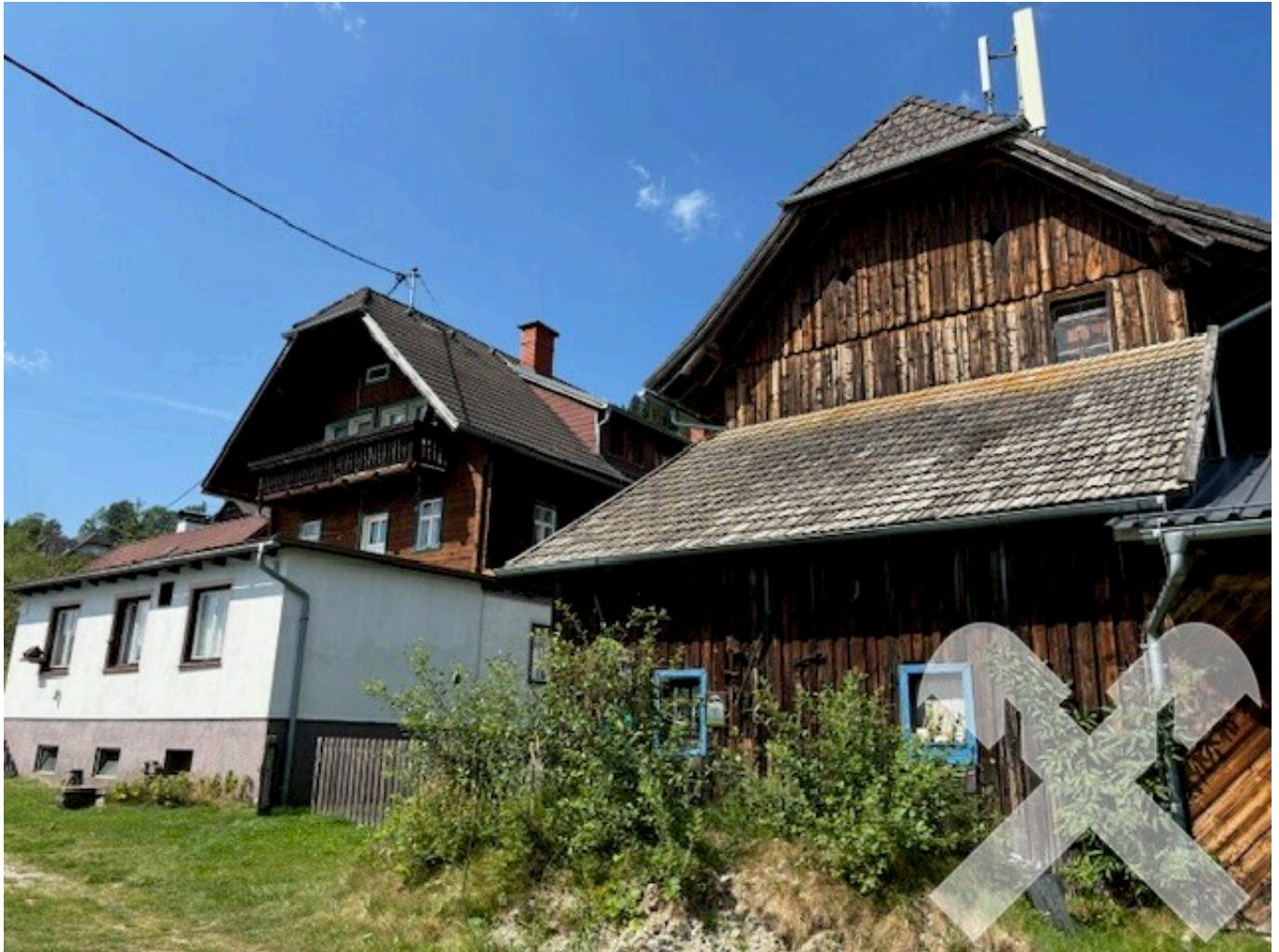
Wohntrakt u. Wirtschaftsgebäude
