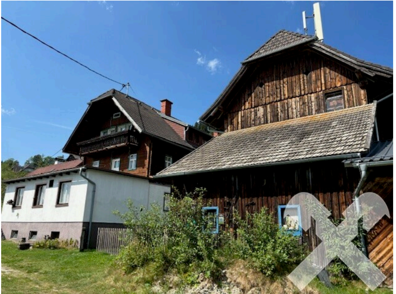
Wohntrakt u. Wirtschaftsgebäude
