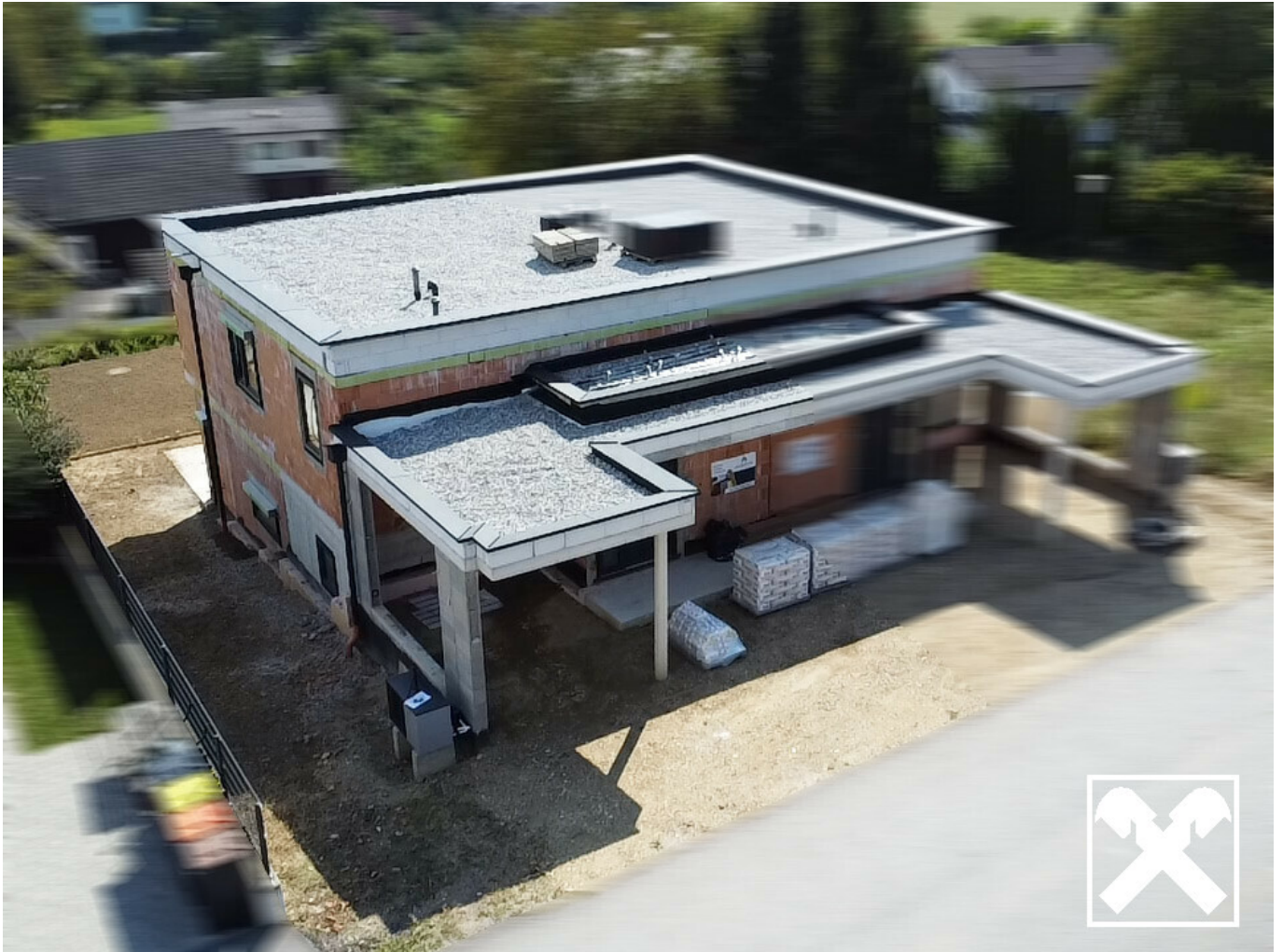
Aussenansicht Doppelhaushälfte / Drohnenbild
