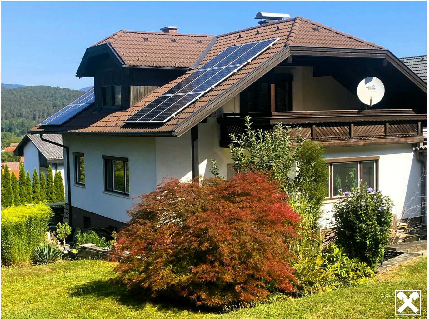
Hausansicht Gartenseite Süd- und West
