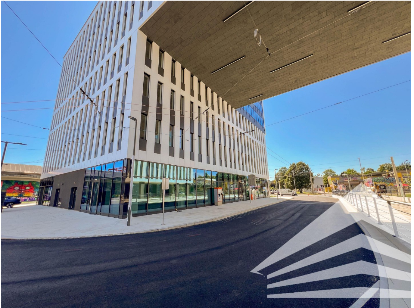
Eingang Bauteil C mit Bushaltestelle
