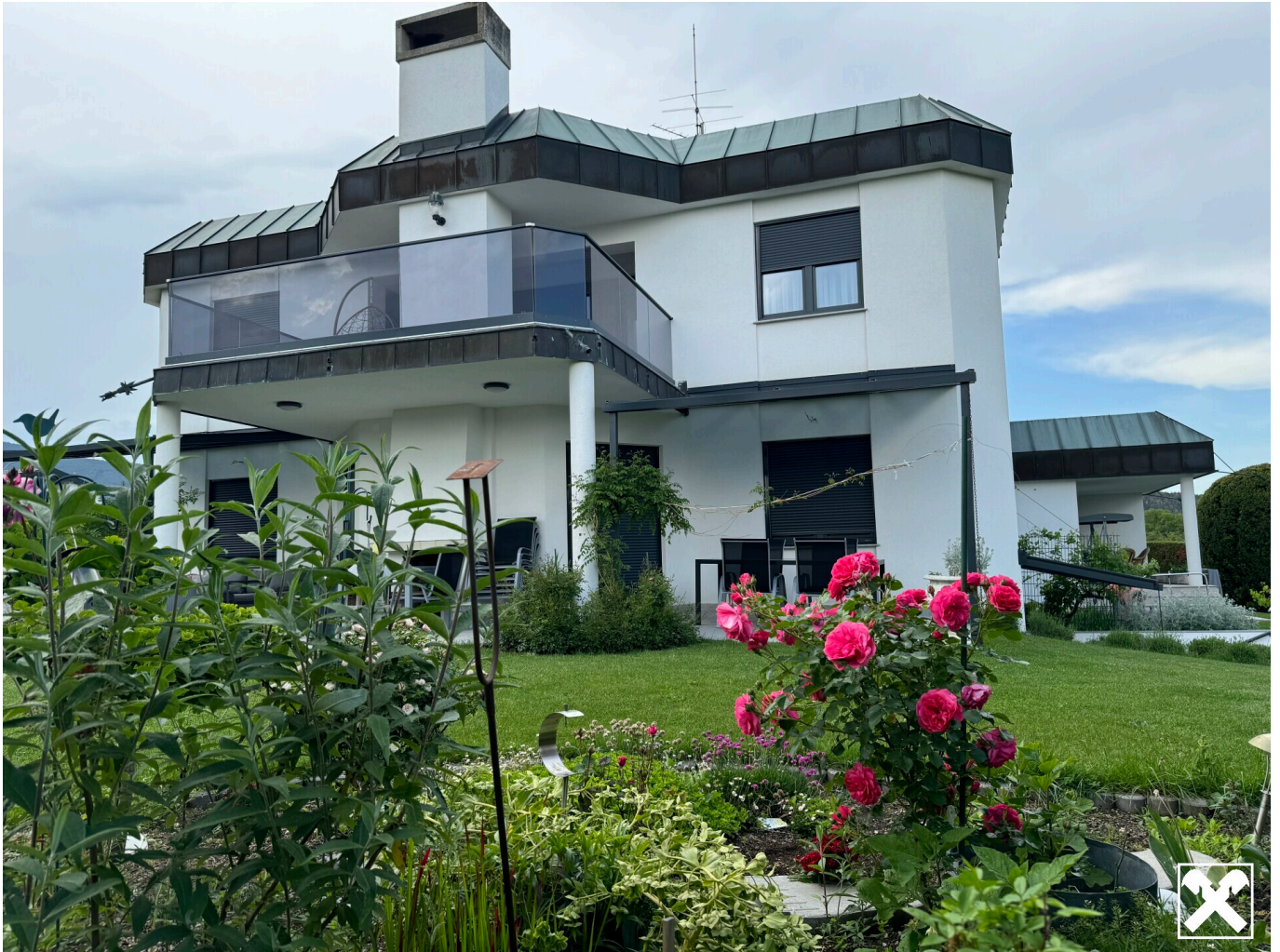
Gartenansicht, Terrasse und Balkon
