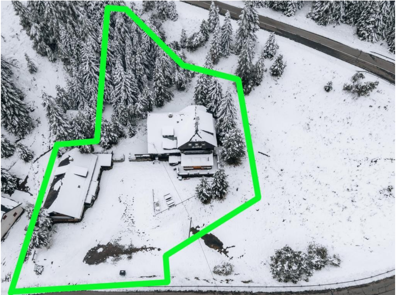
Nahaufnahme Haupt- und Nebengebäude
