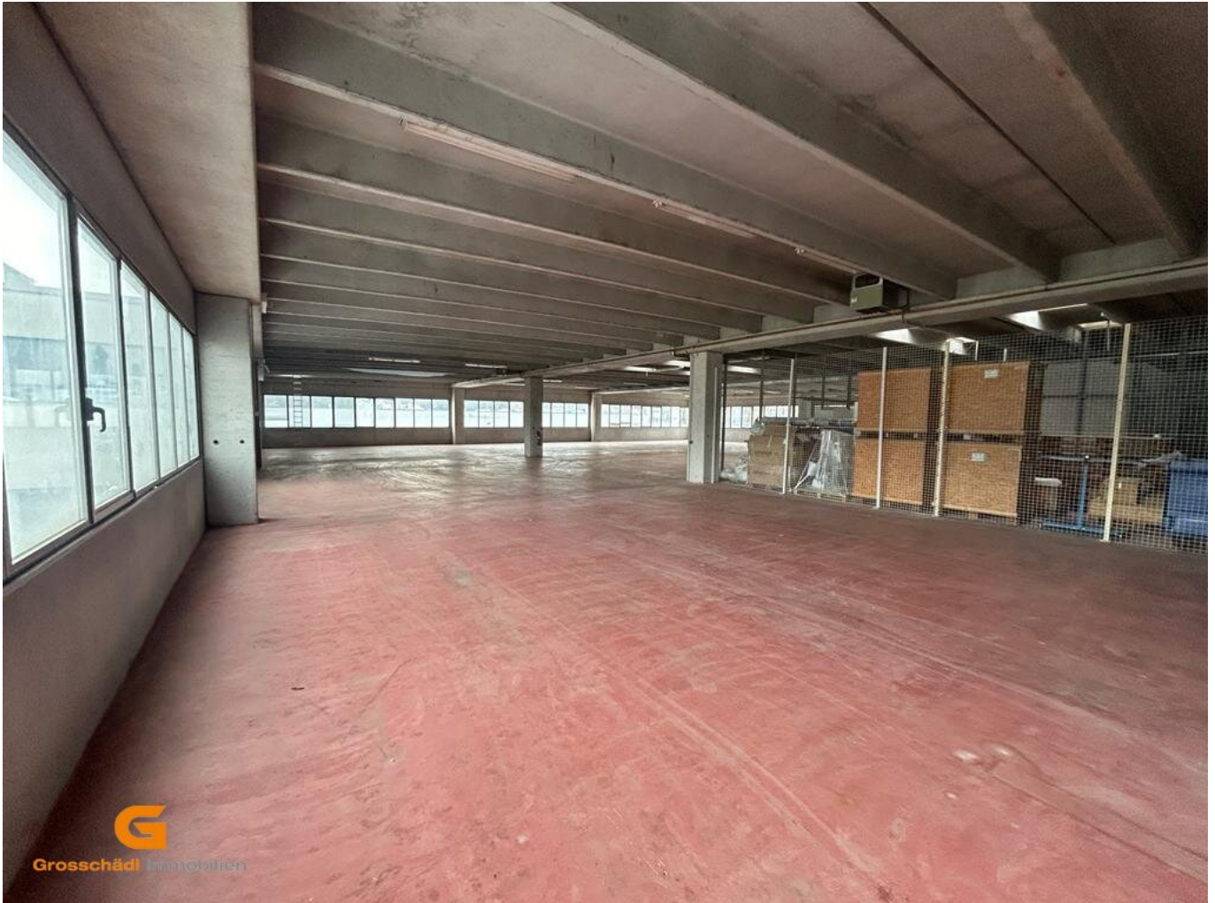
Lager Rückgebäude 1OG
