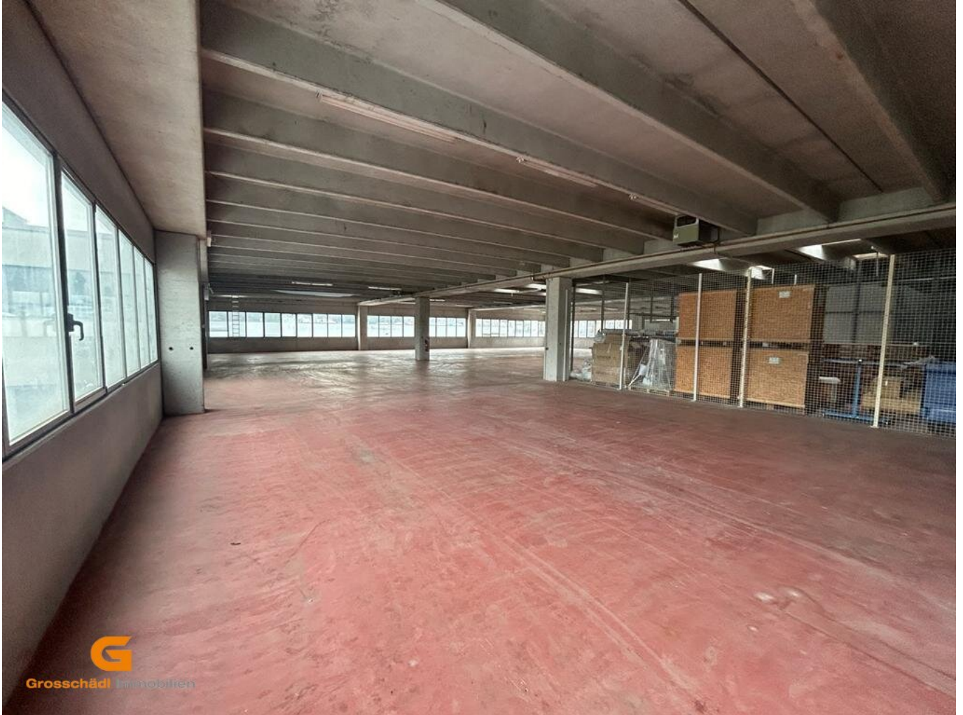
Lager Rückgebäude 10G
