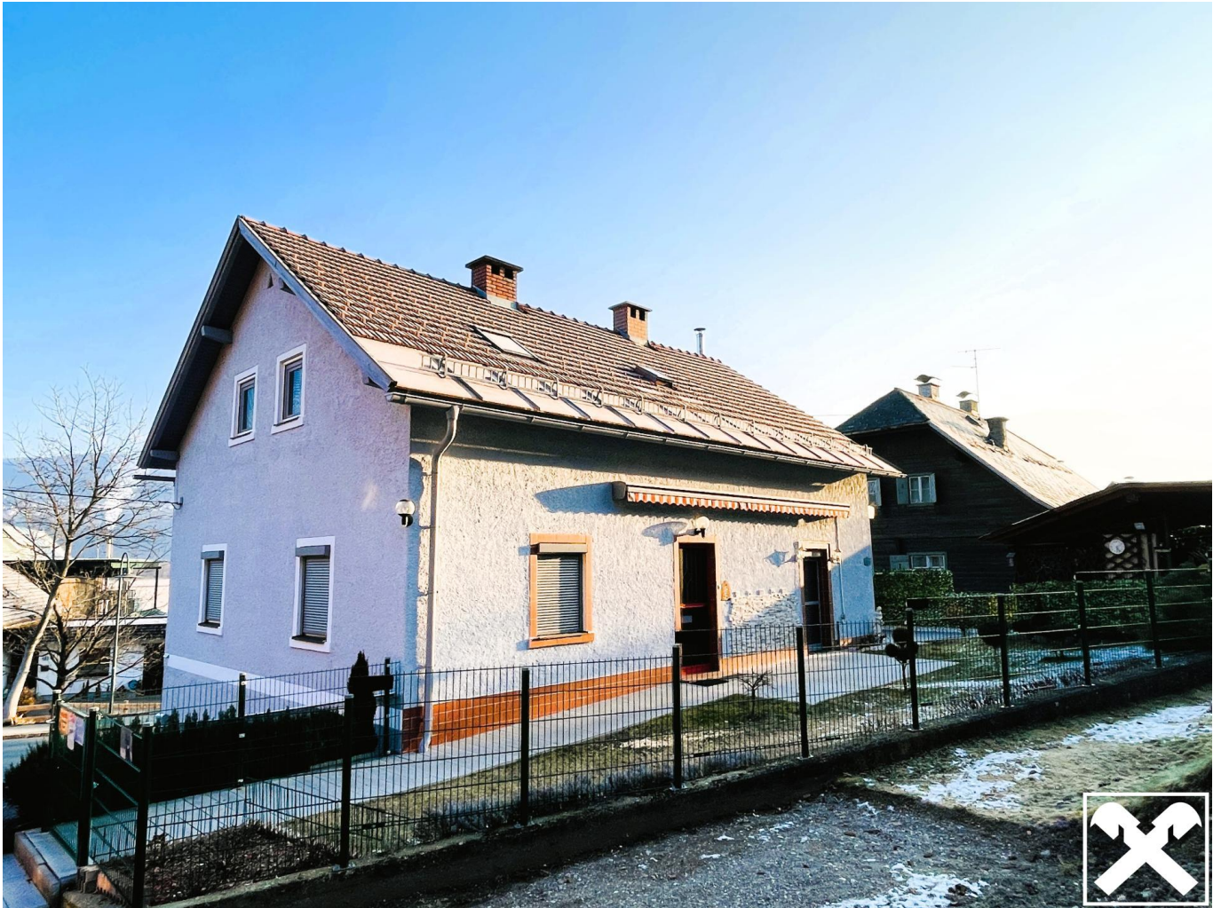
Südansicht mit Eingang
