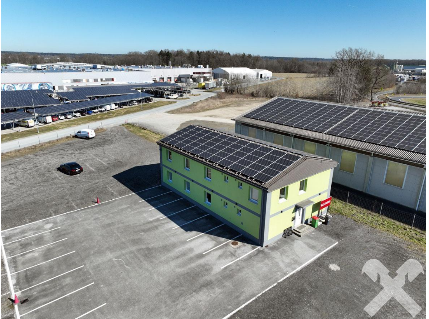
Bürogebäude mit PV-Anlage
