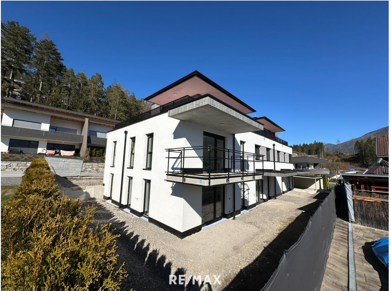
Wohnung - Außenansicht I
