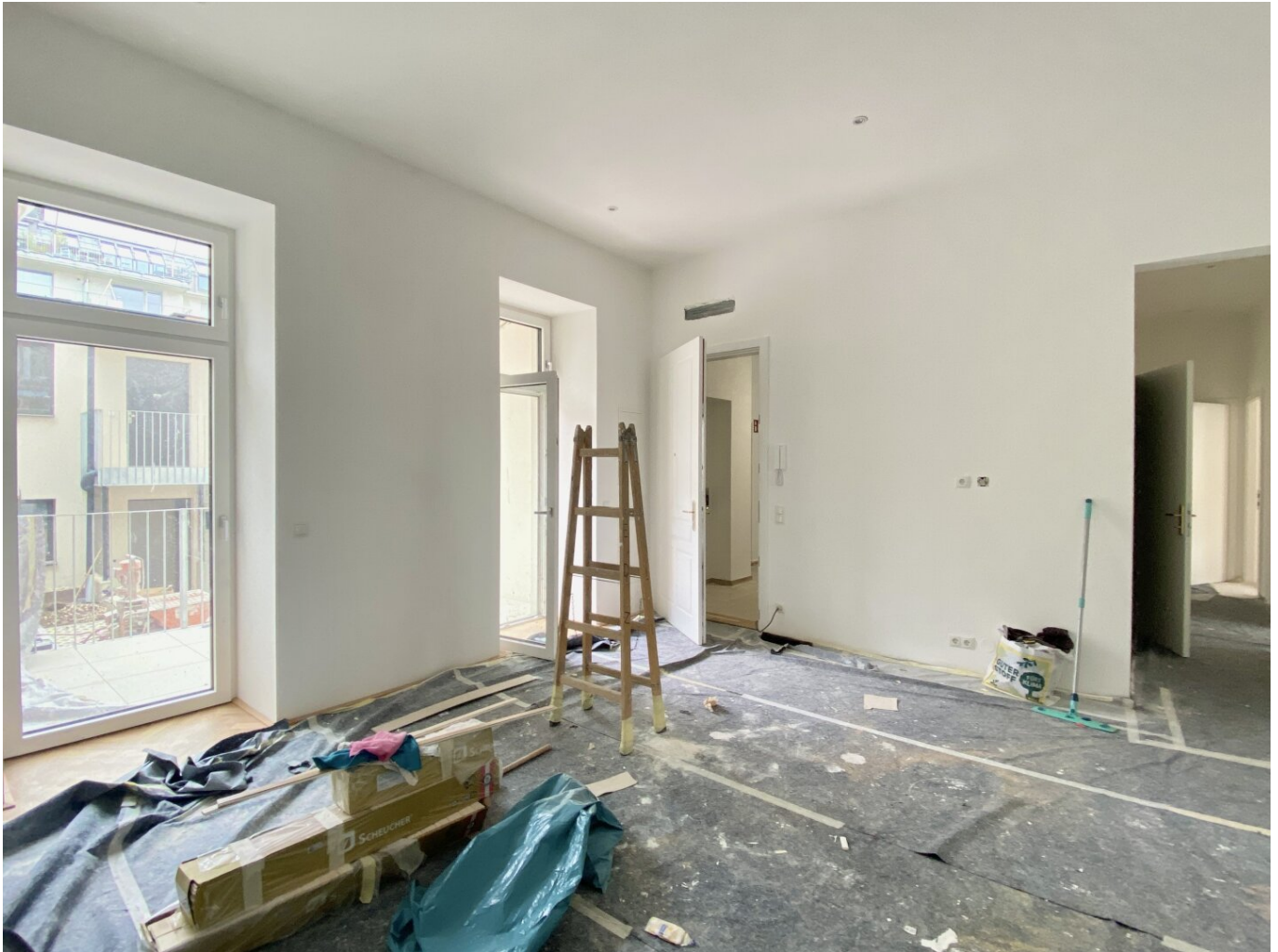
Empfangsbereich mit Innenhof-Terrasse
