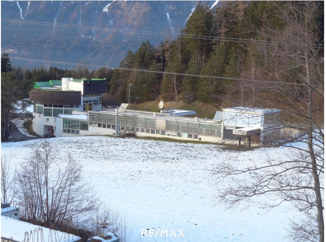
"Bartenbach" - Lacknerbau und Laborgebäude
