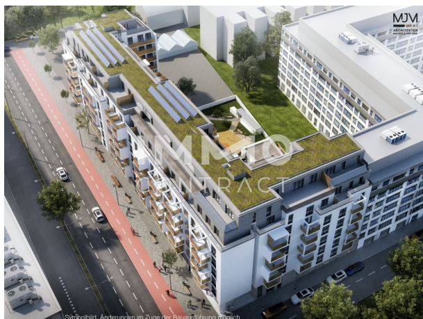
Symbolbild, Änderungen im Zuge der Bauausführung möglich
