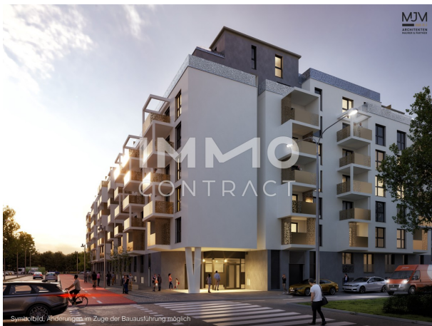
Symbolbild, Änderungen im Zuge der Bauausführung möglich
