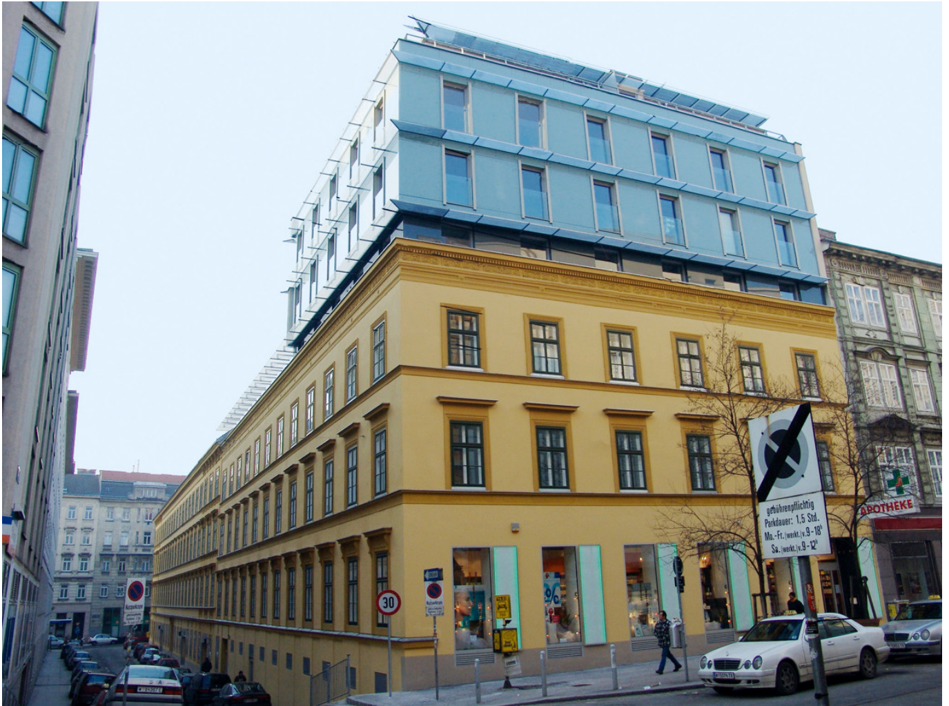
Ansicht Döblergasse nach Revitalisierung
