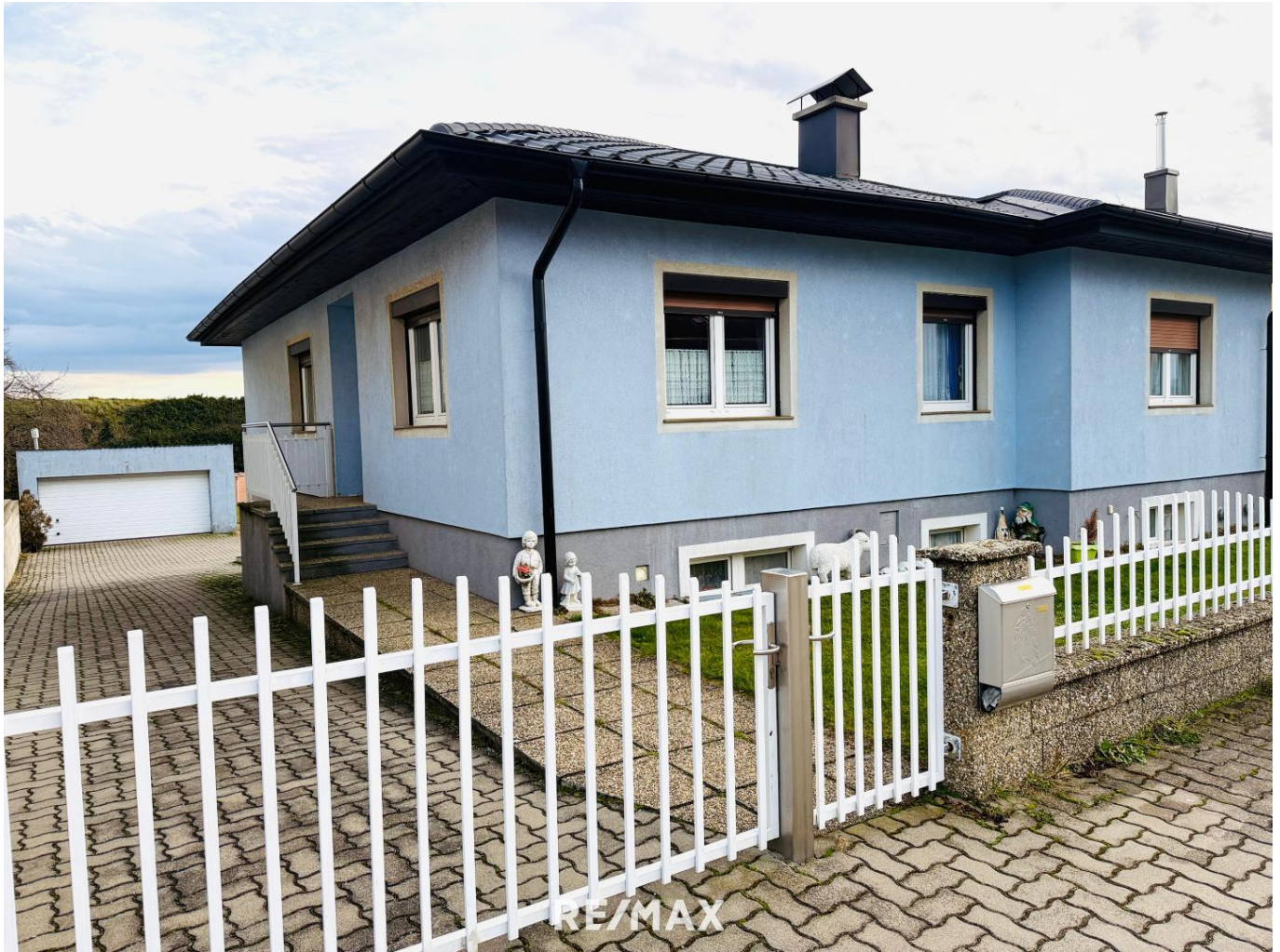
Ansicht von der Strasse
