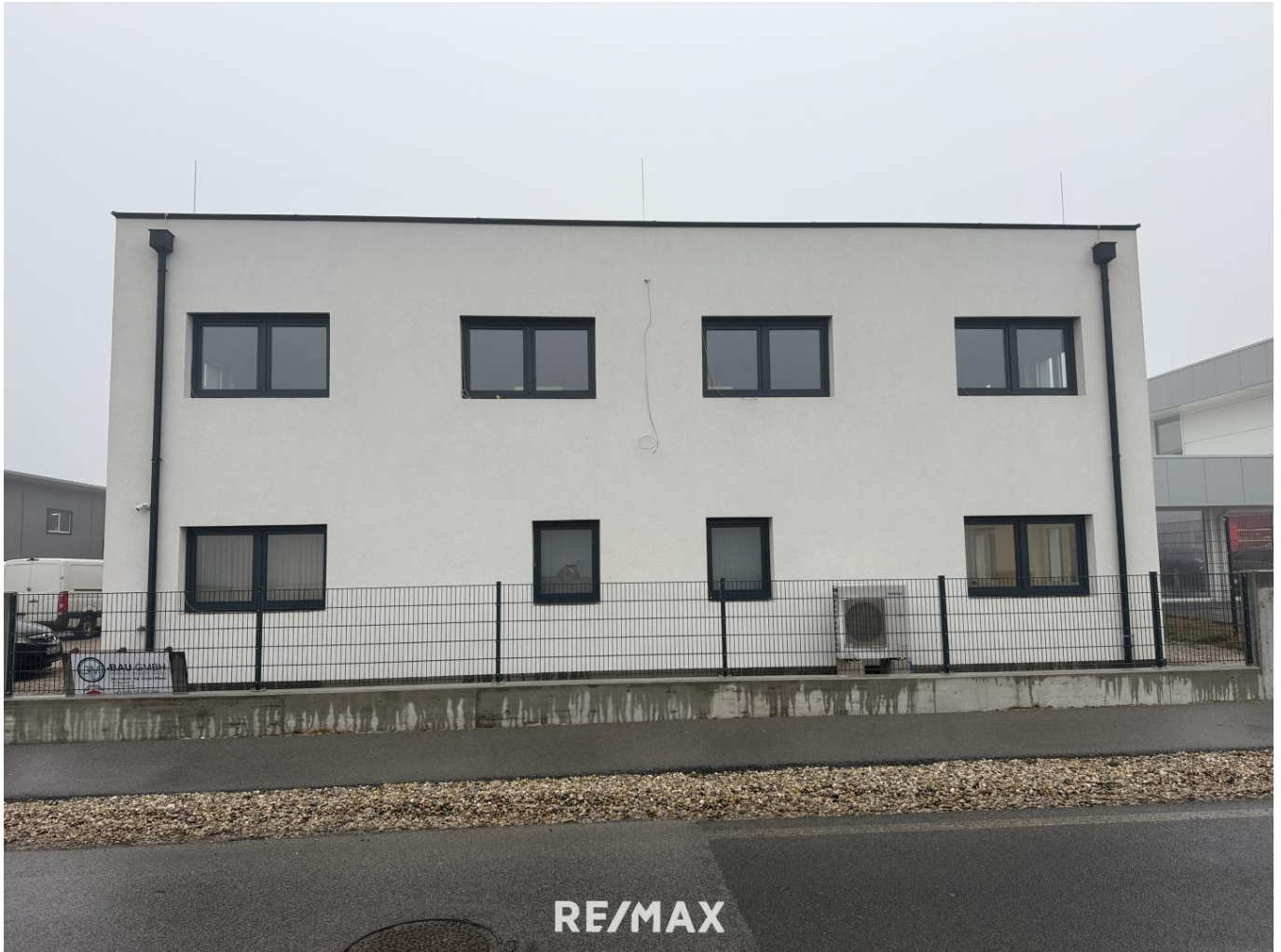
Ansicht von der Strasse
