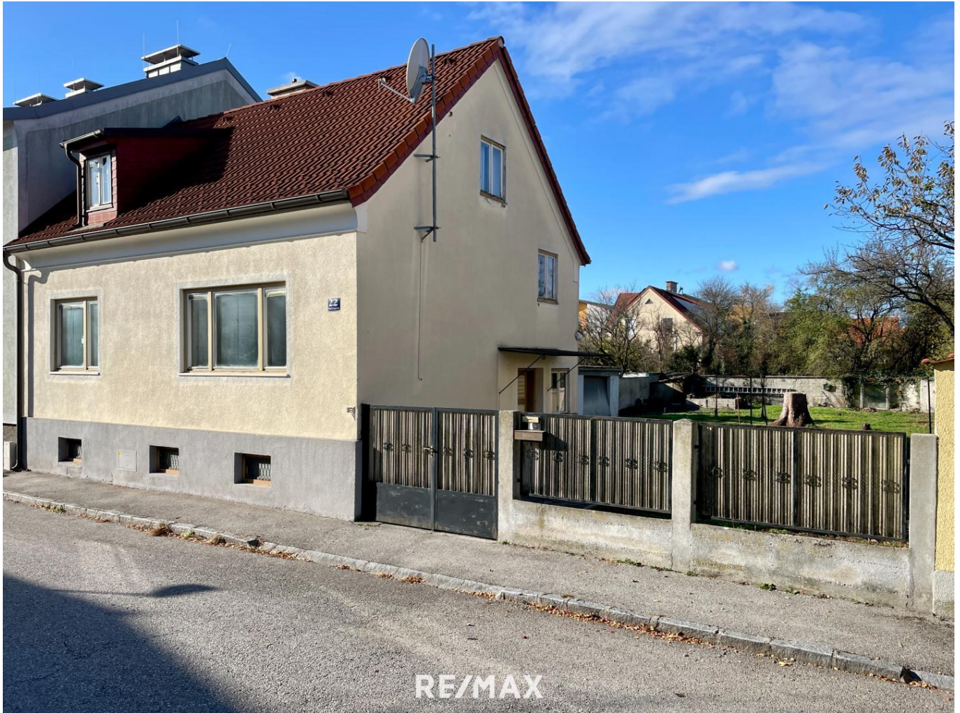
1. Haus von außen
