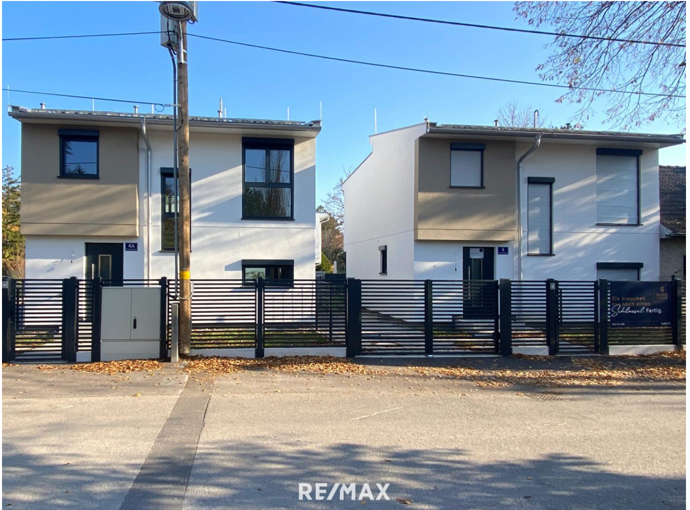
Ansicht von der Strasse
