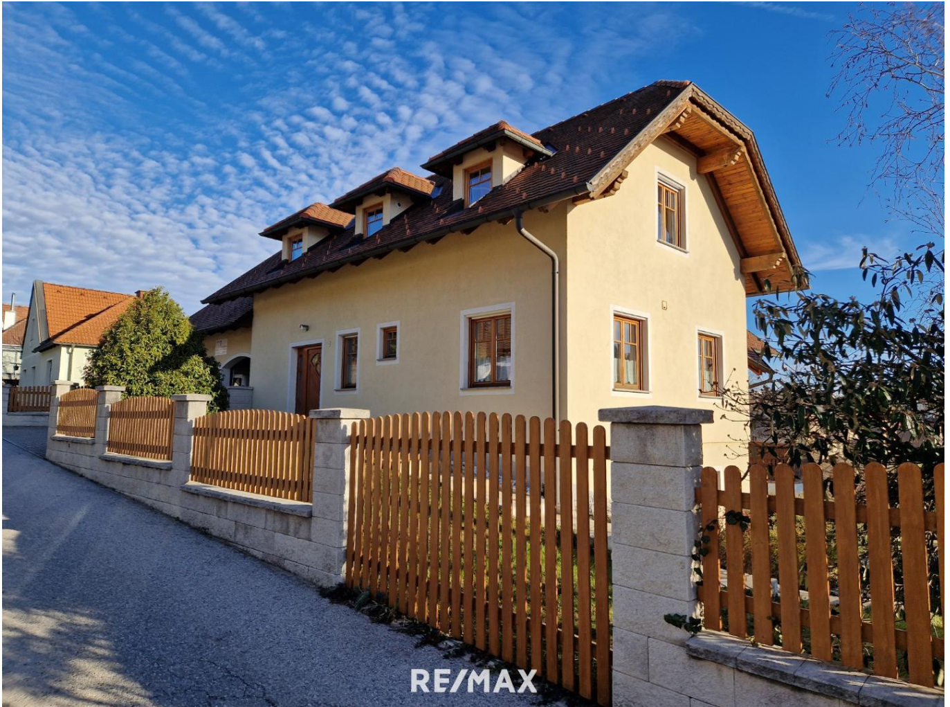
Straßenansicht des Hauses
